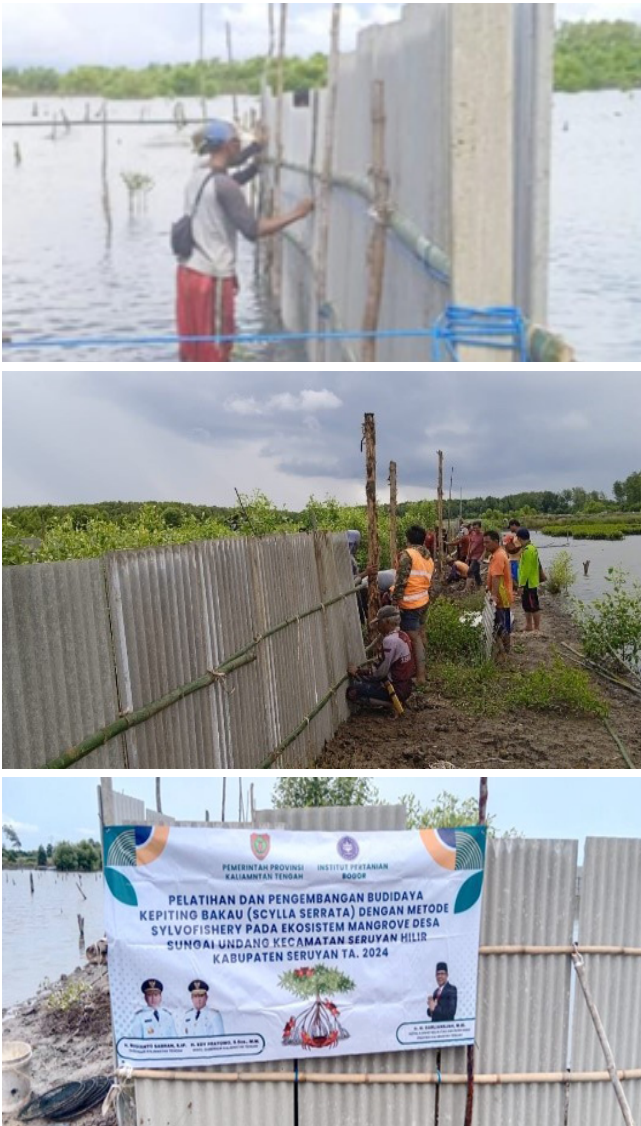
Gambar 5. Karamba pagar asbes yang dibangun untuk pemeliharaan kepiting bakau di Desa Sungai Undang
